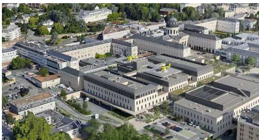
Vue aérienne sur Convergences 1 avec la double hélistation permettant une dépose des patients en urgence vitale au plus près des soins critiques.
